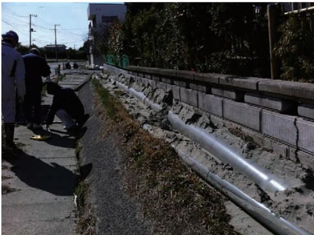
液状化による噴砂と共に浮き上がった下水管
