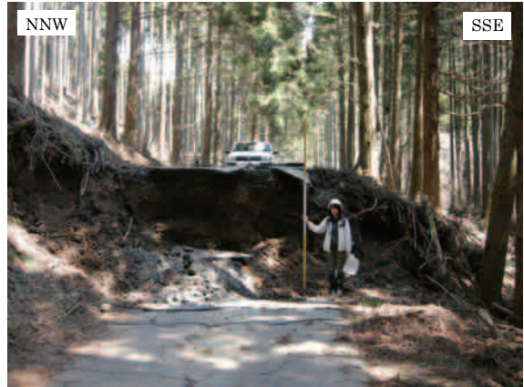
写真 3 道路を横断する地表地震断層
