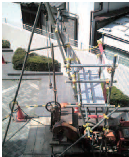
写真. 8 作業床を設置した櫓
