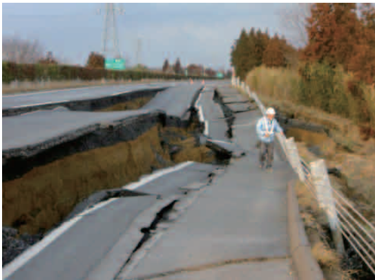
写真-11 技術協力：東日本大震災における盛土被害
