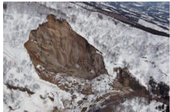
中条川中流左岸の大崩壊（長野県提供）
