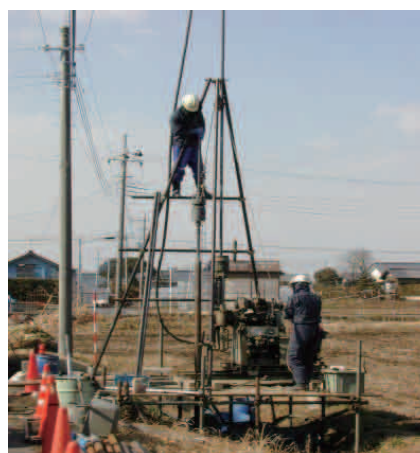
写真. 9 危険な櫓上での作業
