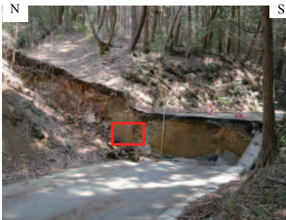
写真 2(1) 道路を横断する地表地震断層 道路を横断し谷沿いに確認できる地表地震断層。アスファルト道路、コンクリート製側溝に上下変位および見かけ右横ずれ変位がみられる。崖高は約 178cm。断層の走向は N11W、傾斜は 80W。[いわき市田人町黒田]
