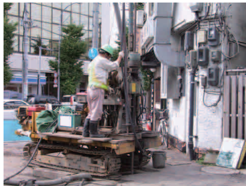
写真 3 ホースを持つ掘削作業 (違反行為です)
