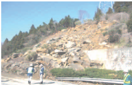
写真-12 技術協力：東日本大震災における切土被害
