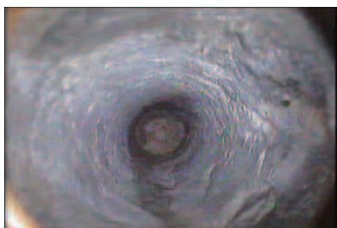
図3 削孔したロックボルト孔の孔壁
