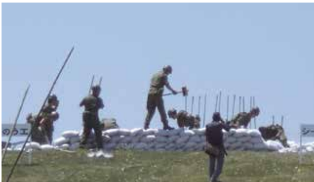
写真1 積土のう工法
