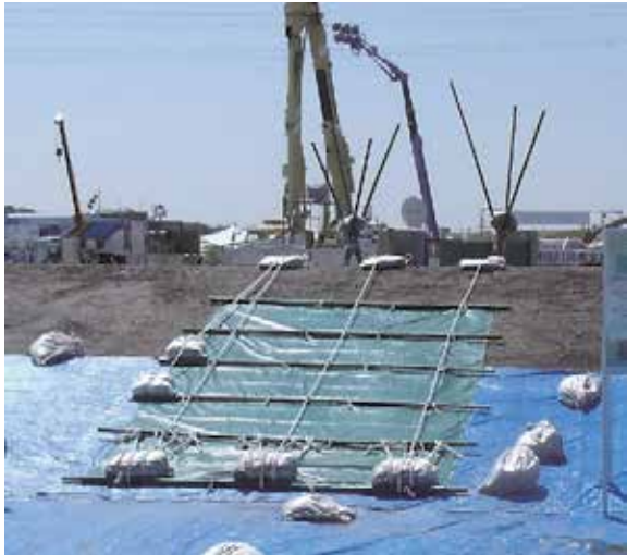
写真4 シート張工法
