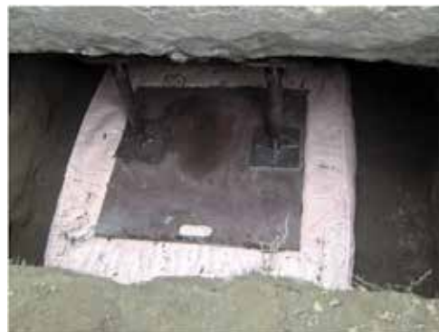
【油圧ジャッキをサポートジャッキに交換】
