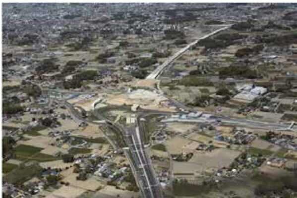
写真-1 桶川北本 IC (平成 25 年 5 月撮影)
