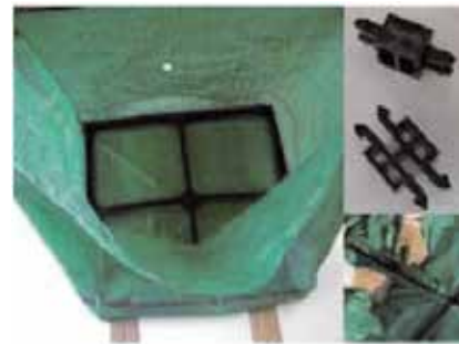
写真-2 ガイドゲージをD・BOXにセット
