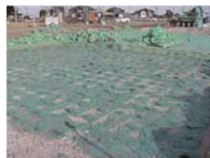
写真-4 D・BOX-SS45の敷設状況
