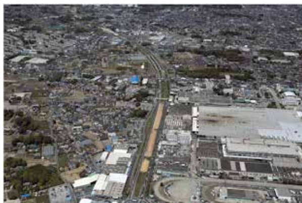
写真-2 (主)川越上尾線交差部(平成 25 年 5 月撮影)
