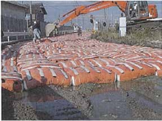
写真-12 D・BOXの敷設状況
