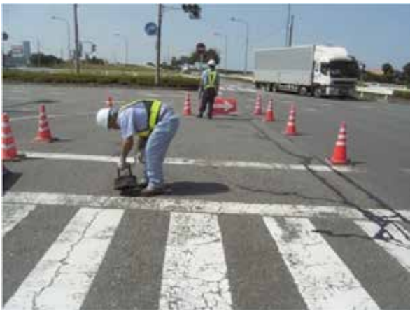
写真-9 道路のひび割れ補修作業の状況
