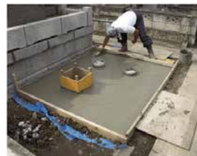
写真-9 基礎コンクリートの施工
