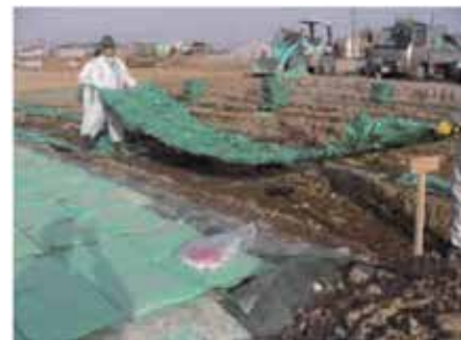
写真-3 D・BOX-SS45の作業状況
