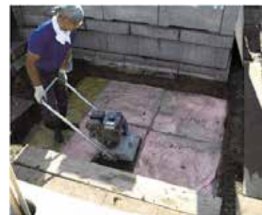
写真-7 D・BOX-SS90 を 3 段敷設
