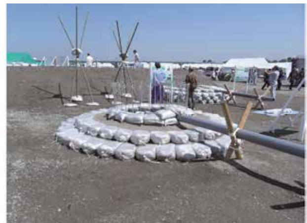
写真3 釜段工法
