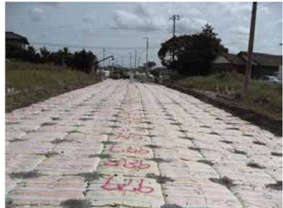
写真-15 D・BOXの敷設状況 (敷設後)
