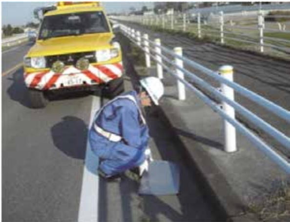
写真-8 巡回（落下物改修）の状況
