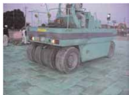
写真-5 タイヤローラーによる転圧
