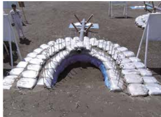
写真2 月の輪工法
