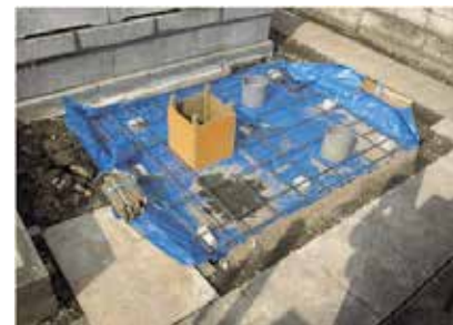
写真-8 D・BOX 上のブルーシートによる縁切
