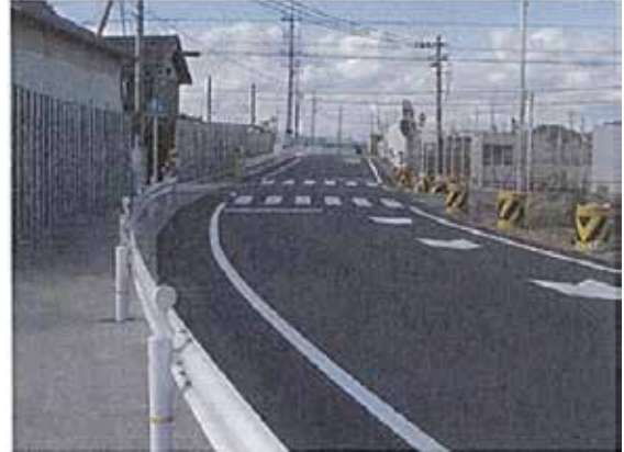
写真-13 完成時の状況
