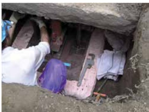
【油圧ジャッキを使い住宅をリフトアップ】
