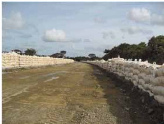
写真-14 D・BOXの敷設状況 (敷設前)
