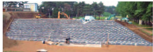
図 3 農村工学研究所内での越流許容型ため池堤体の実証試験
