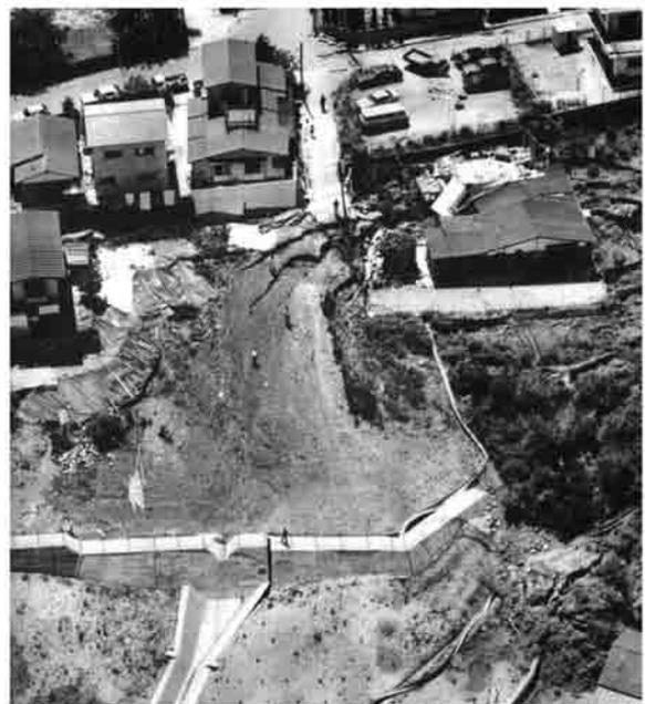
図2 谷埋め型大規模造成地の被災事例
