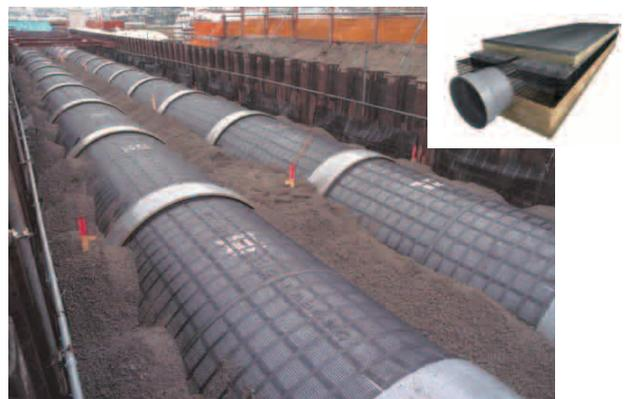
図 4 ジオシンセティックスを用いたパイプラインの浅埋設工法（直径 2,400mm）
