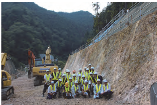
写真一 4 付替県道切土斜面
