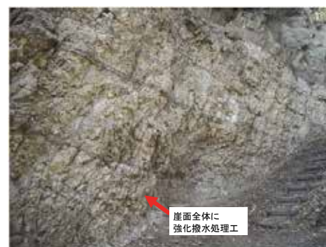
写真-7 強化撥水処理工の施工箇所
