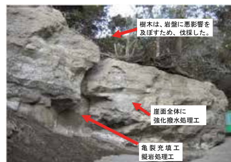
写真-6 亀裂充填工の施工箇所
