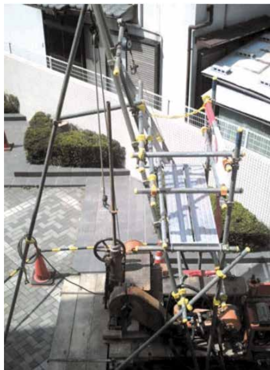
写真—1 安全櫓設置例
