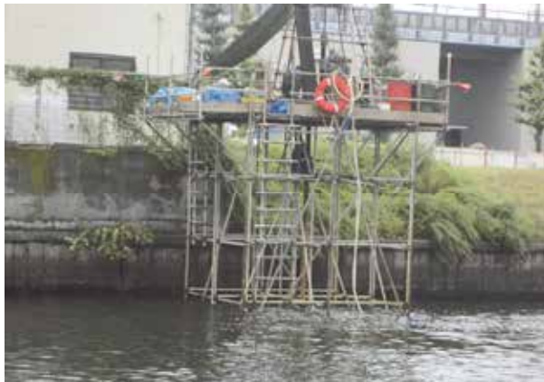
写真-3 拡張足場写真
