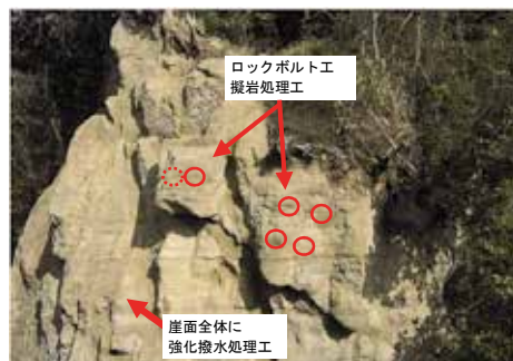
写真-5 ロックボルト工の施工箇所
