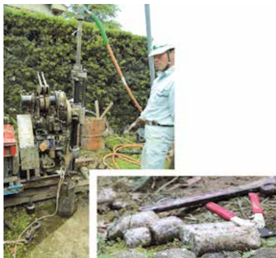
写真-6 庭先のボーリングで出てきた転石
