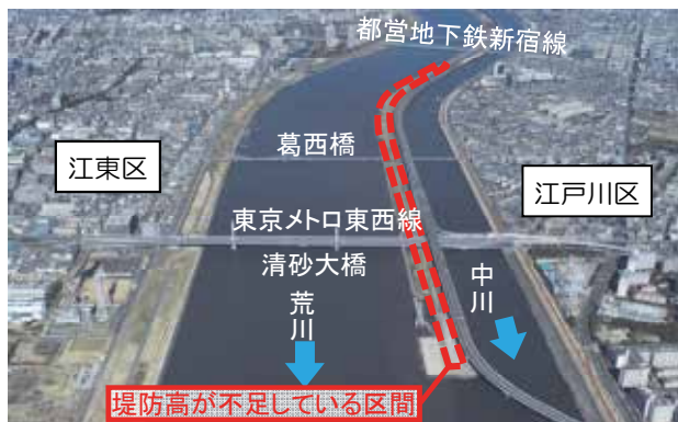
写真－３ 堤防高が不足している区間
