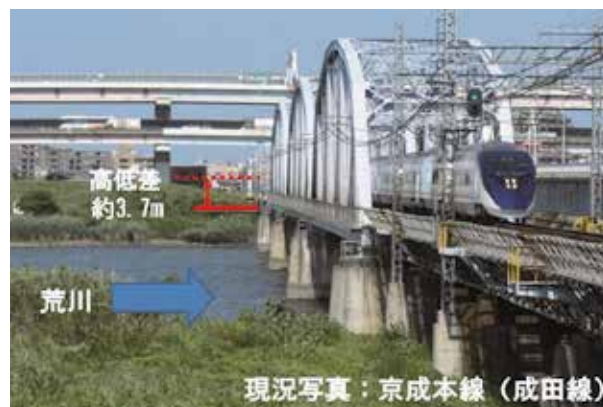
写真－1 実際の京成本線荒川橋梁
