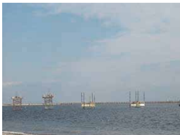
写真-1 現場状況写真
