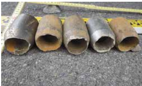
シューの摩耗・破損
